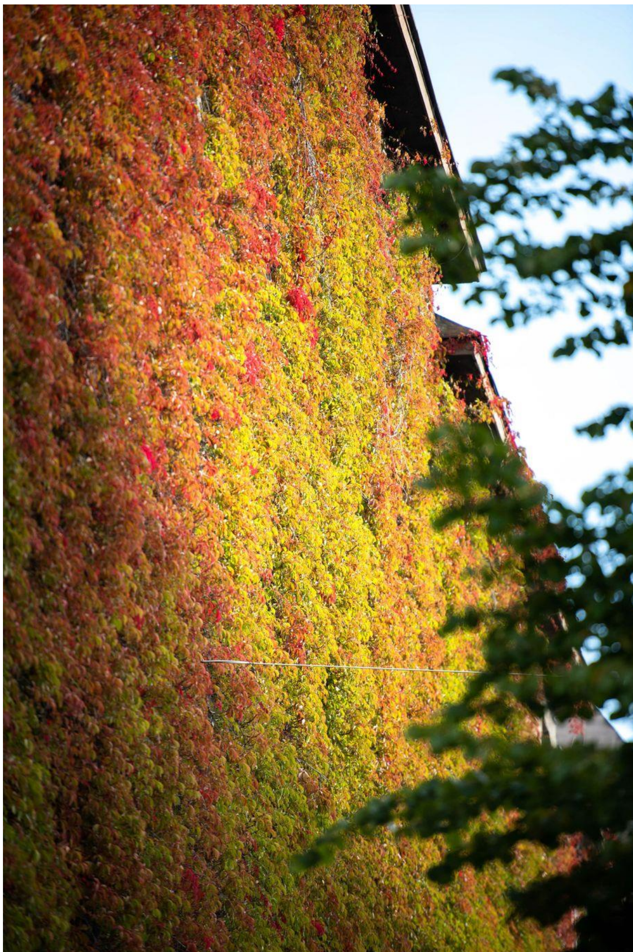
Viherseinät ovat mahdollisuus tuoda vihreyttä kaupunkirakentamiseen. PETE ANIKARI
